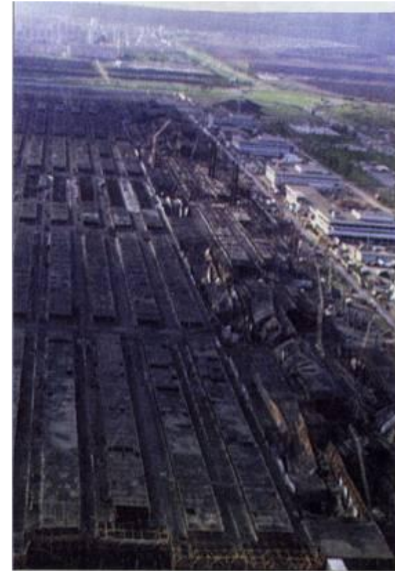
Последствия пожара на заводе двигателей АО «КамАЗ»
