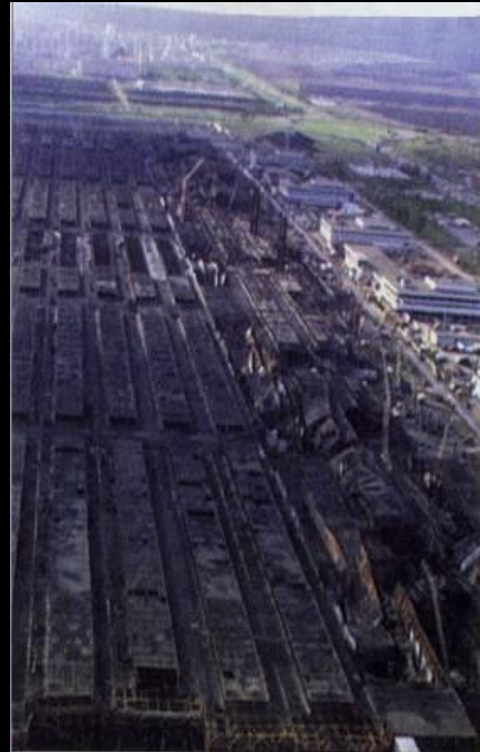
Последствия пожара на заводе двигателей АО «КамАЗ»
