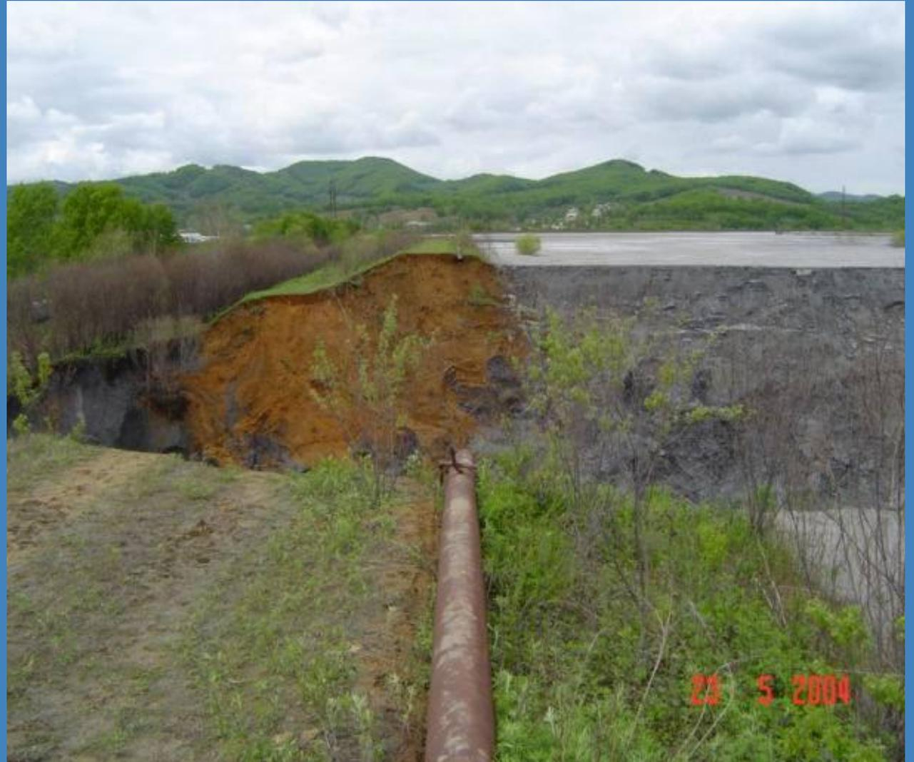
Земляные плотины наиболее распространены и наиболее древний тип плотин. Обычно их строят небольшой высоты и значительно реже средней высоты. В настоящее время к этому типу относят плотины, у которых объем тела на 50% и более выполнен из мелкозернистых грунтов. По способу производства работ земляные плотины делят на два типа: насыпные и намывные.
