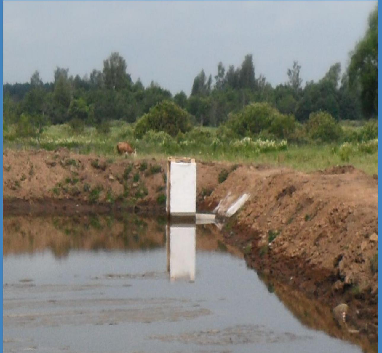
Обвалование на картах намыва подразделяется на первичное, отсыпанное до начала намывных работ, и попутное, устраиваемое в процессе намыва плотины для каждого яруса или слоя укладки намывного грунта.
