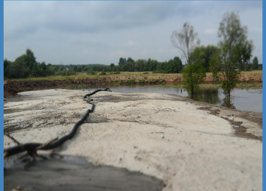
Предельная интенсивность наращивания плотин при намыве устанавливается с учетом водоотдачи укладываемого в сооружения грунта, инфильтрации из прудка и поверхностных слоев намыва, а также фильтрационной способности грунта основания. Условием ограничения интенсивности намыва являются заметные выходы фильтрационной воды на откосы и начинающееся оползание откосов.
