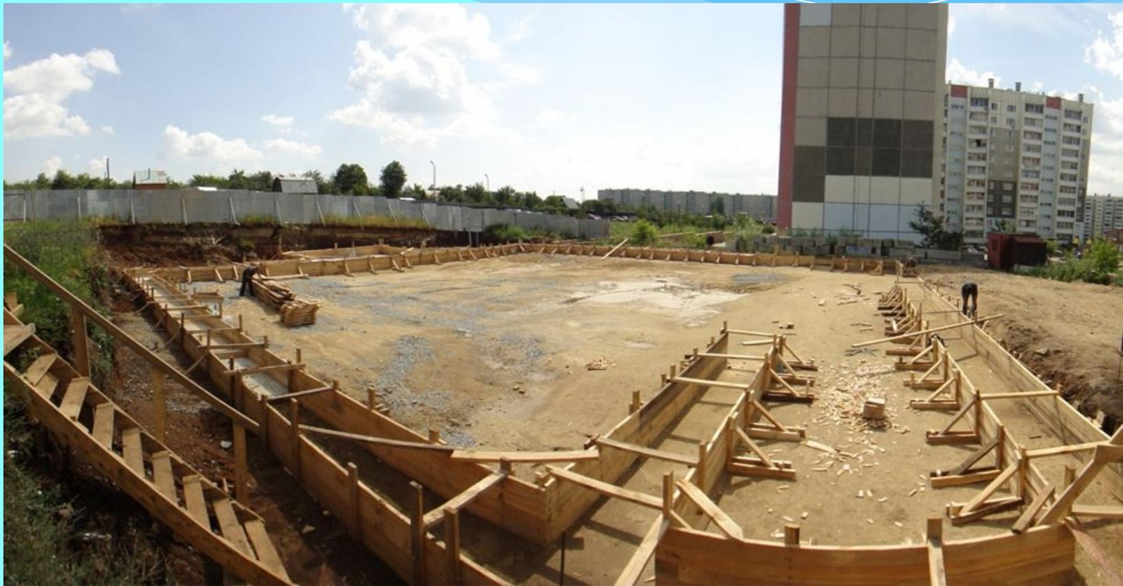
**далее были установлены железобетонные блоки и возведен фундамент. К концу года на фундамент были положены первые кирпичи будущих стен цоколя.**
