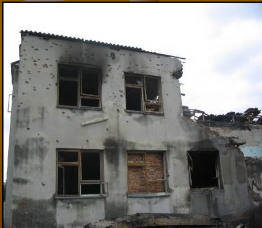
Школа, разрушенная в ходе теракта.
