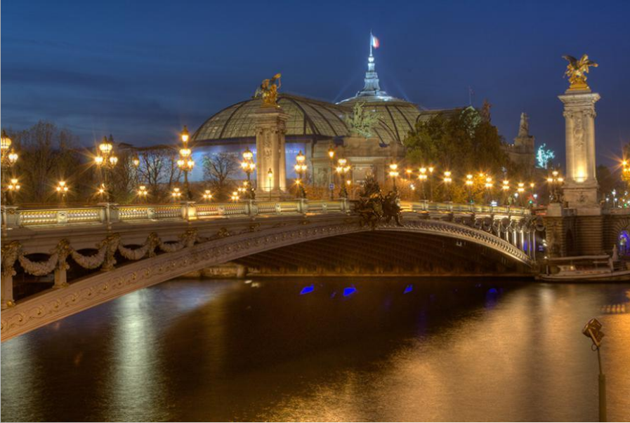
Мост Александра III
