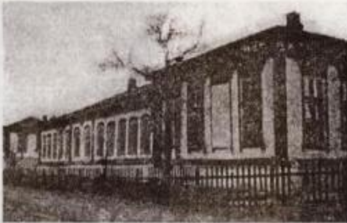
Здание школы в г.Калаче, где в период зимнего наступления Красной Армии 1942—1943 гг. помещался штаб Юго-Западного фронта.
