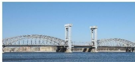
Финляндский железнодорожный мост
