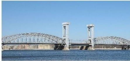
Финляндский железнодорожный мост
