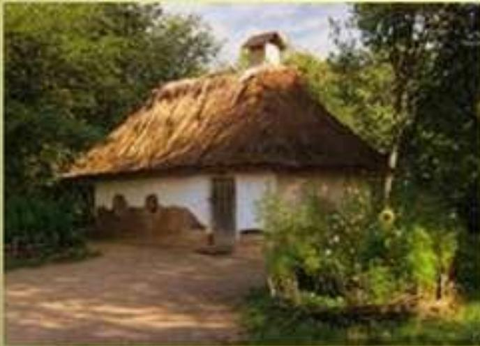
В строительстве мазанки использовались местные строительные материалы, такие как глина, солома, камыш, дерево. Стены традиционной мазанки состоят из каркаса (тонкие ветки дерева, или даже хвороста) или сырцового кирпича и обмазываются глиной (откуда и название).
