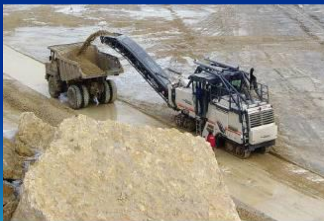
Фото 2 Комбайн 2200 SM на проходке добычной заходки вдоль выработки, оконтуривающей площадку испытаний
