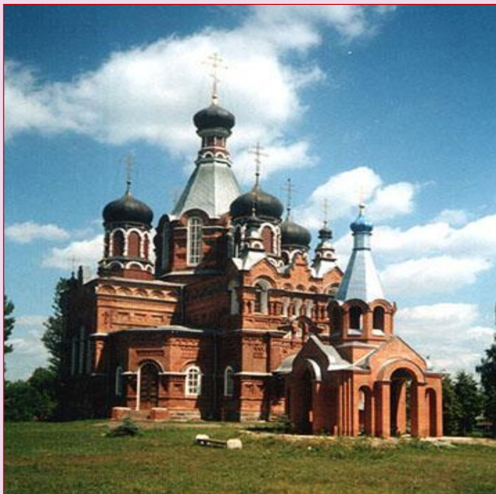
Ярцево, Петропавловская церковь в псевдорусском стиле, построенная в 1915-1924.
