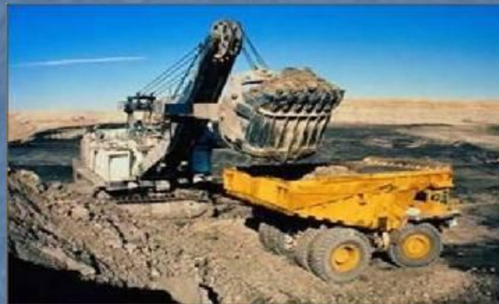
В открытых котлованах-карьерах.
