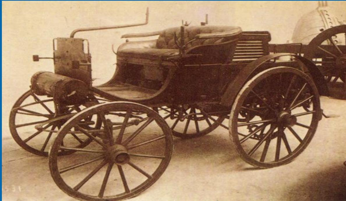
Экипаж приводился в движение мускульной силой двух человек, управляющими этим экипажем. Она имела 4 колеса. Кузов подвешивался к раме на нескольких ремнях. Двойной приводной механизм размещался на небольшой площадке позади пассажирских сидений. К этой же площадке выходили тяги рулевого управления.
