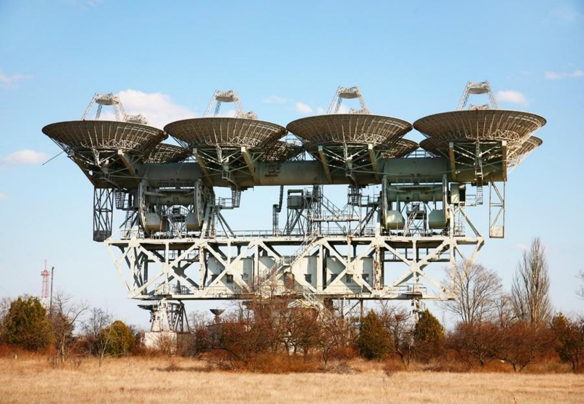
центр управления полетами Витино
