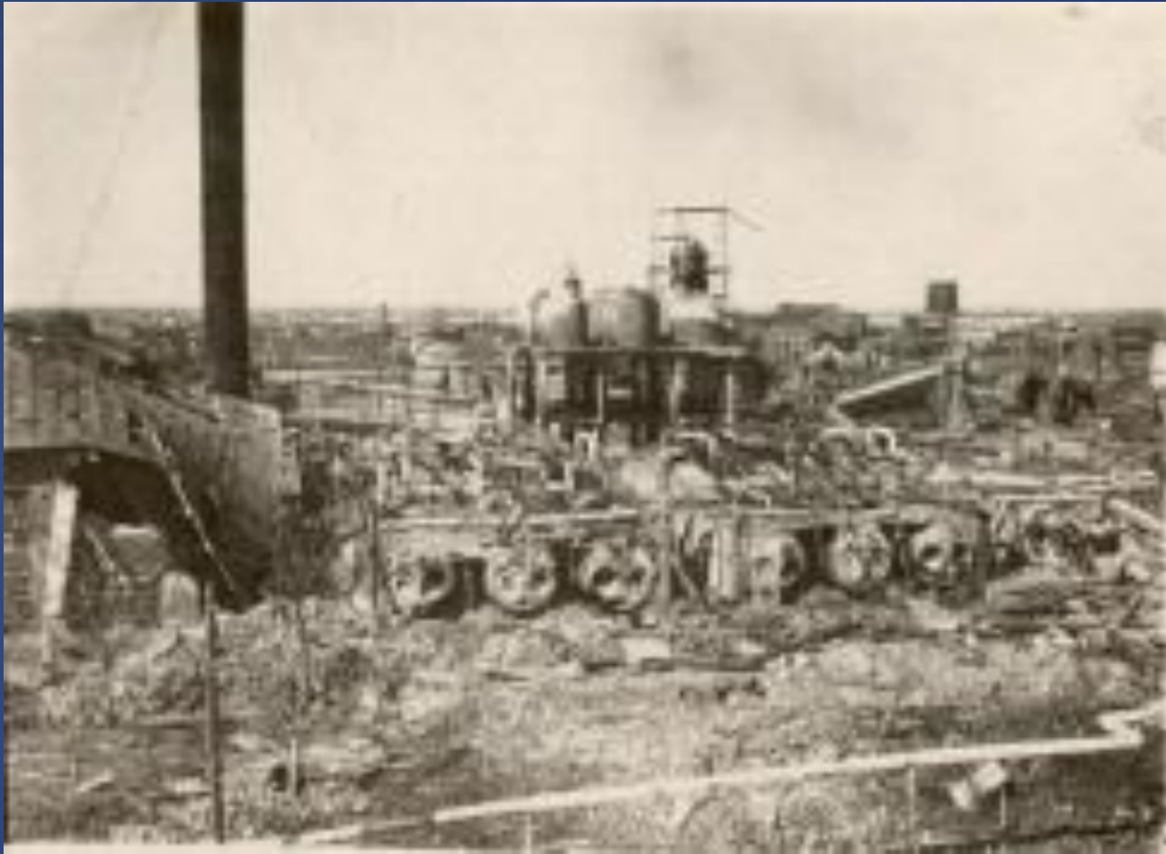
После оккупации. Нефтеперегонный завод в г. Краснодаре
