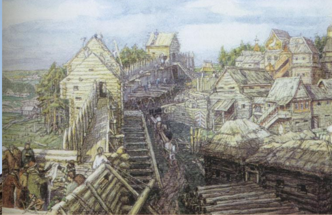
А. ВАСНЕЦОВ Строительство деревянных стен Кремля
