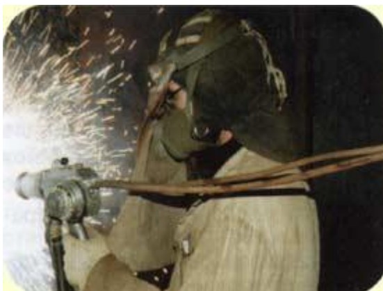
Нанесение алюминиевого ЭМП на стенку нефтяного резервуара
