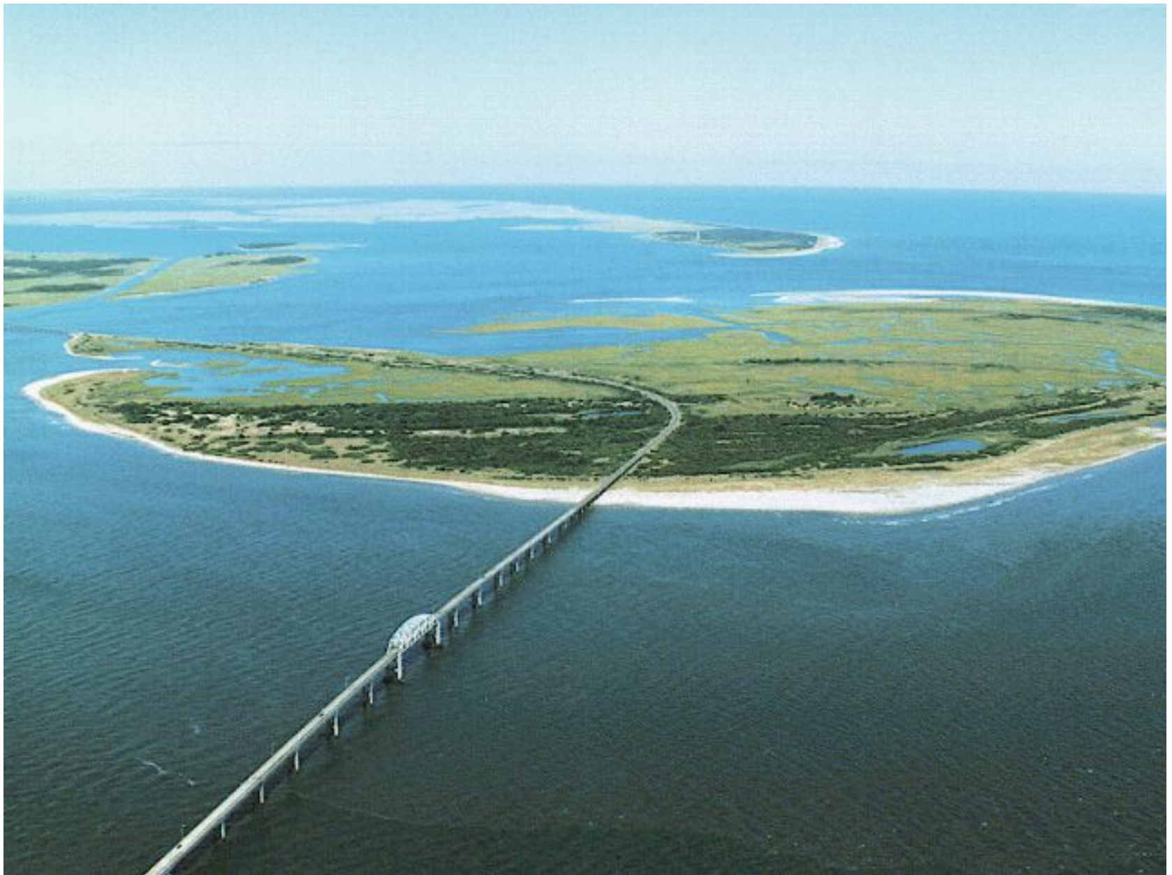
Мост-туннель в Вирджинии, США
