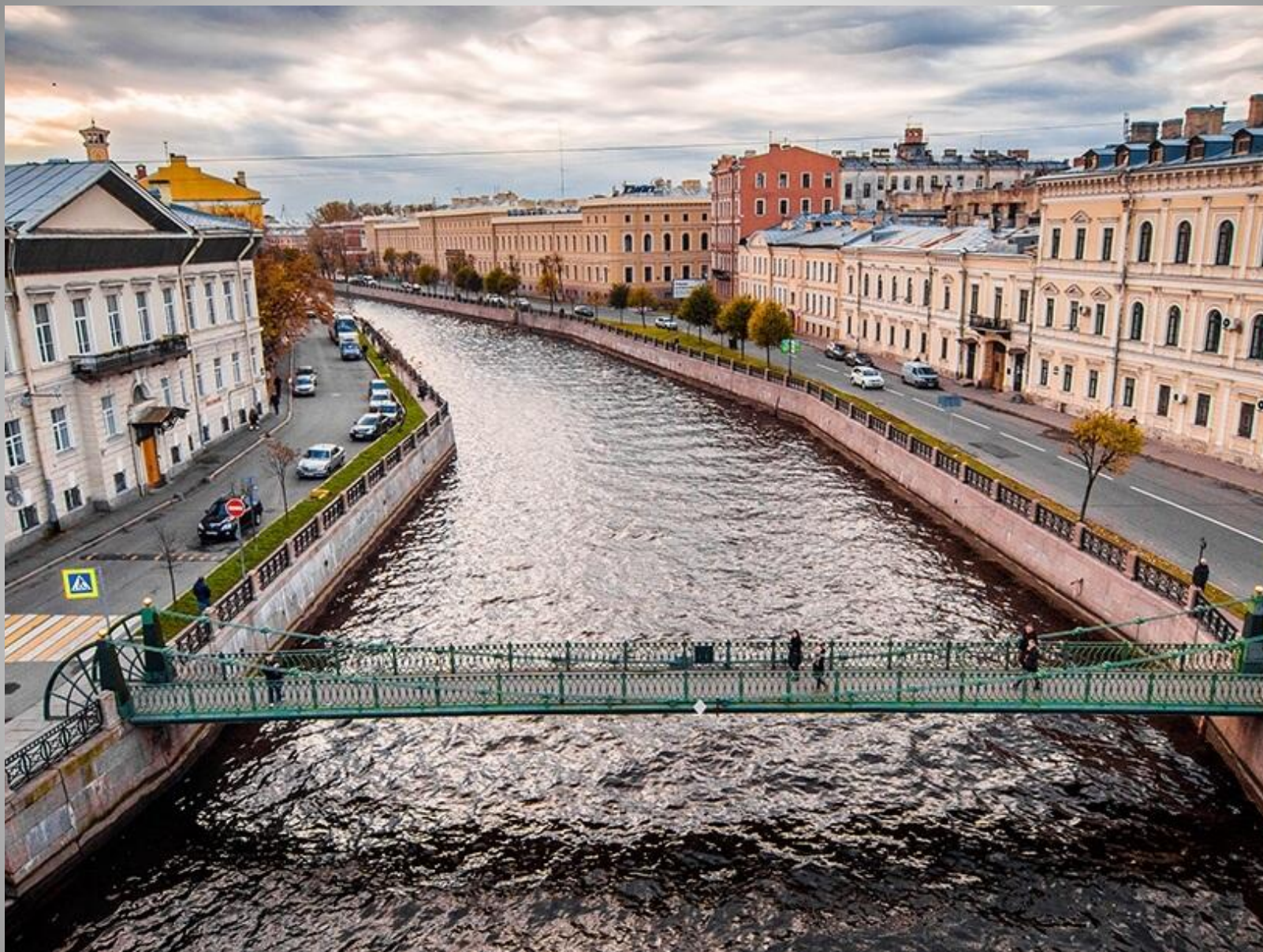
Пешеходные, висячие мосты. Почтамтский пешеходный мост перекинут через реку Мойку
