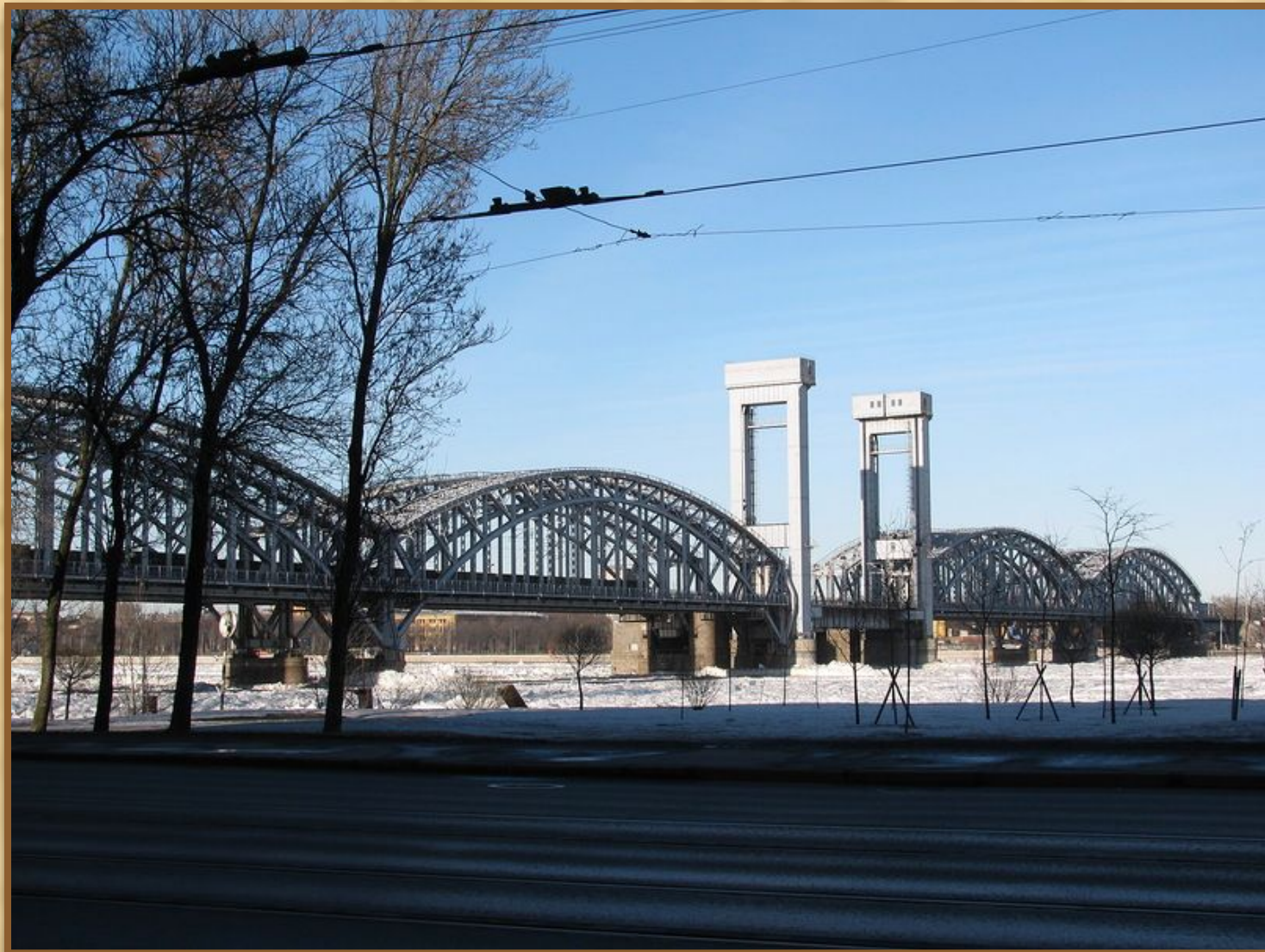
Финляндский железнодорожный мост
