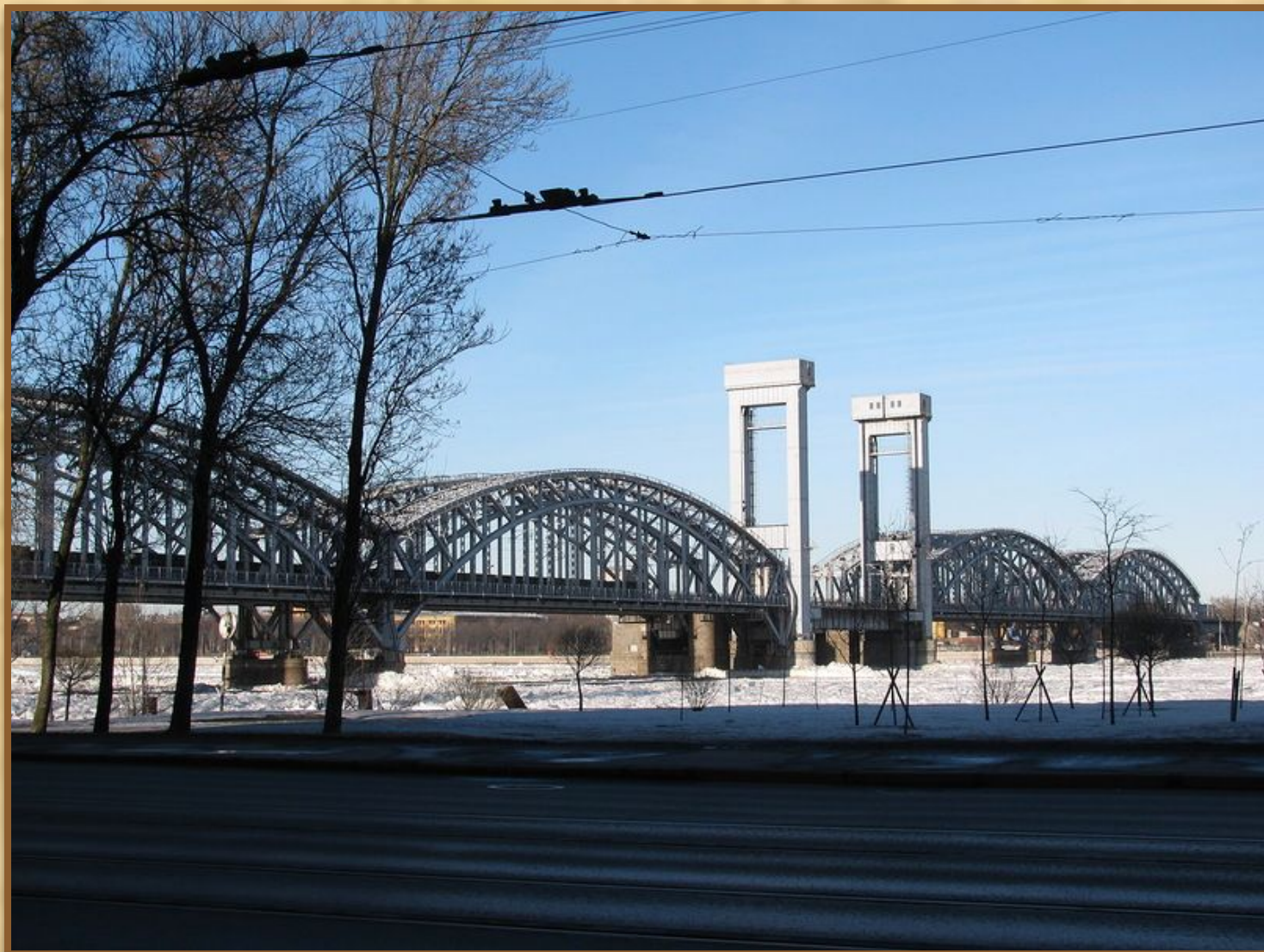
Финляндский железнодорожный мост
