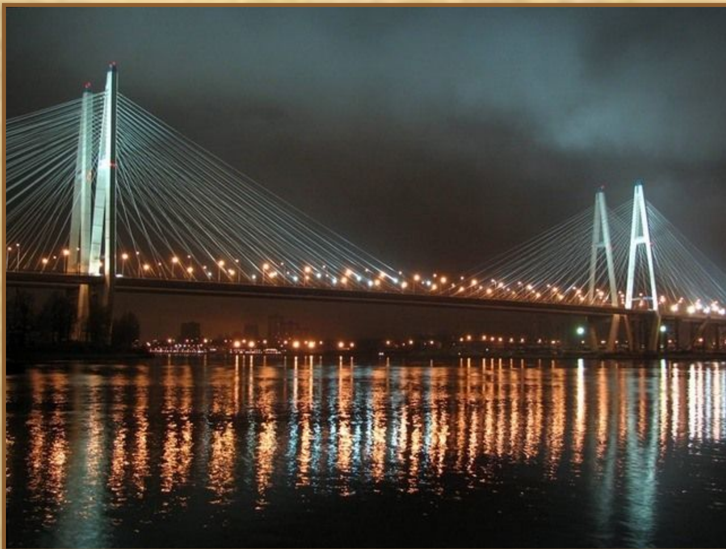
Большой Обуховский мост
