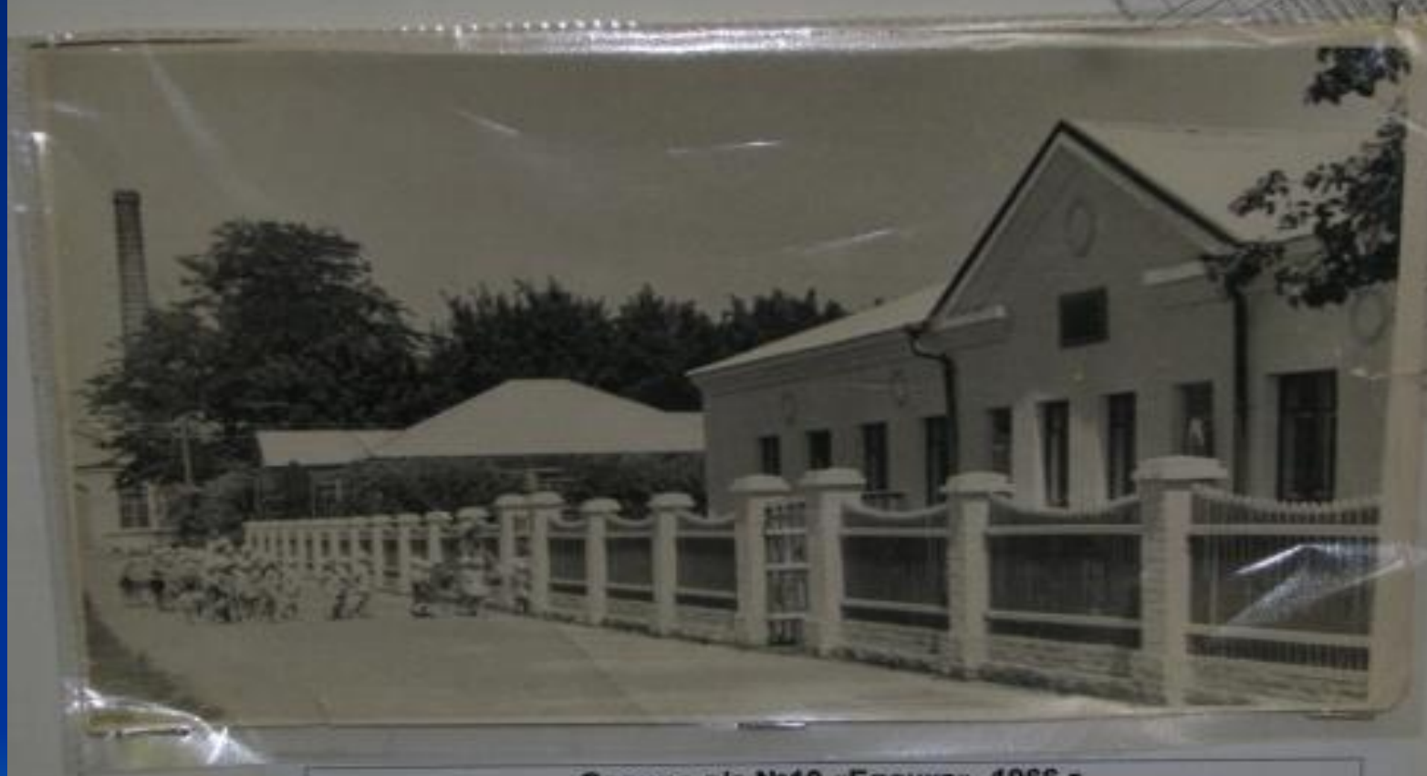
Здание д/с №10 «Елочка». 1966 г.
