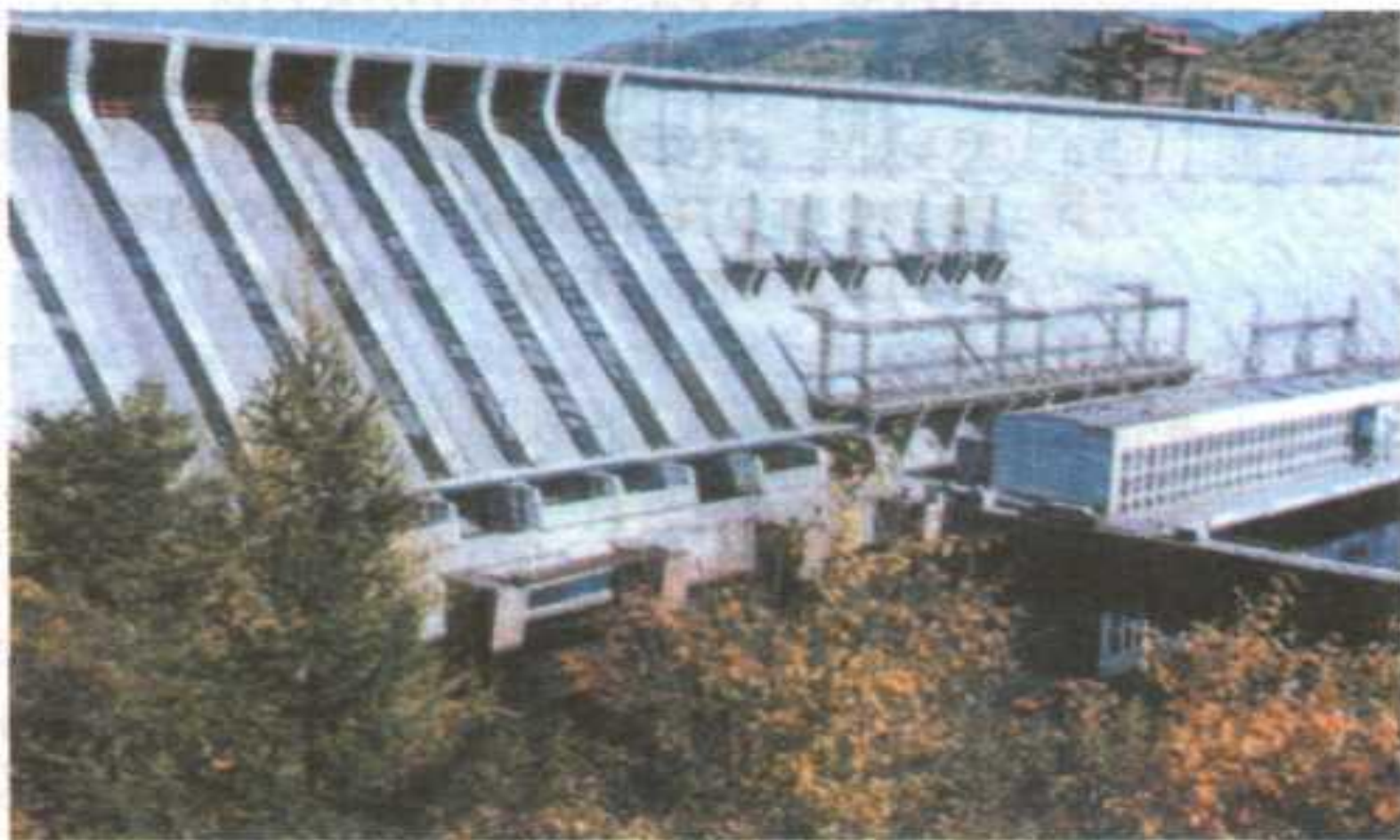
Плотина Зейской гидроэлектростанции
