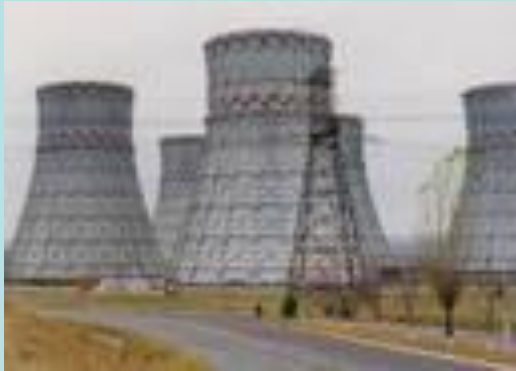
ТЭС Тепловая электростанция
