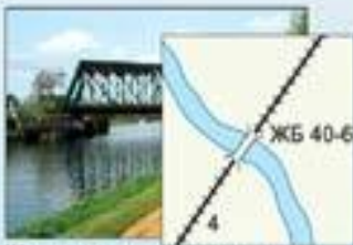
Железная дорога и железобетонный мост
