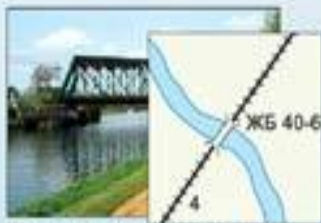
Железная дорога и железобетонный мост
