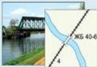
Железная дорога и железобетонный мост
