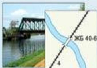
Железная дорога и железобетонный мост
