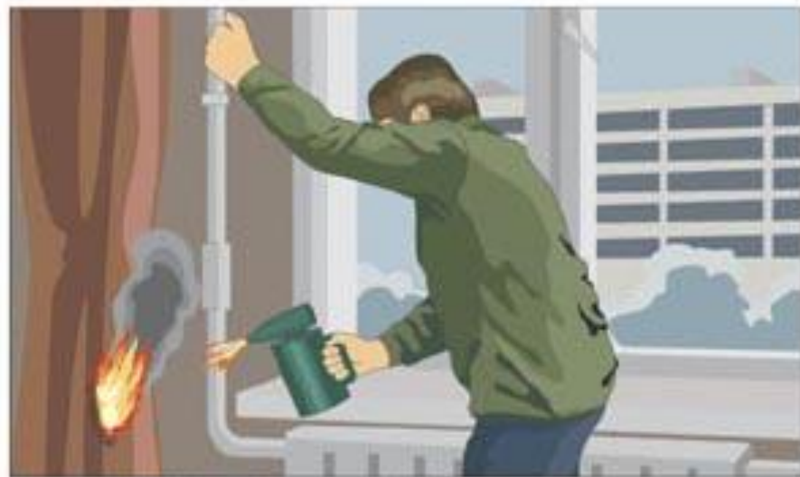
Отогревание замерзших труб газовыми лампами и факелами
