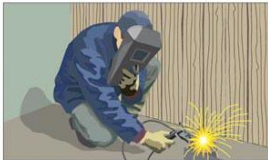
Нарушение правил проведения сварочных работ
