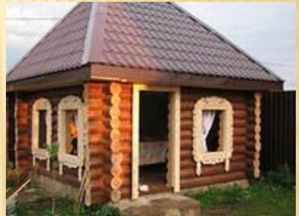
СРУБ - ЭТО ДЕРЕВЯННОЕ СООРУЖЕНИЕ БЕЗ ПОЛА, ПЕРЕКРЫТИЙ, ЛЕСТНИЦ, ДВЕРЕЙ И ОКОННЫХ РАМ, ВОЗВЕДЕННОЕ ИЗ ГОРИЗОНТАЛЬНЫХ БРЁВЕН ИЛИ БРУСЬЕВ.
