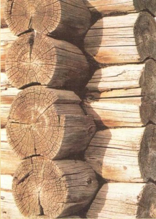
Бревна сруба обязательно прокладывали мхом (для теплоизоляции).
