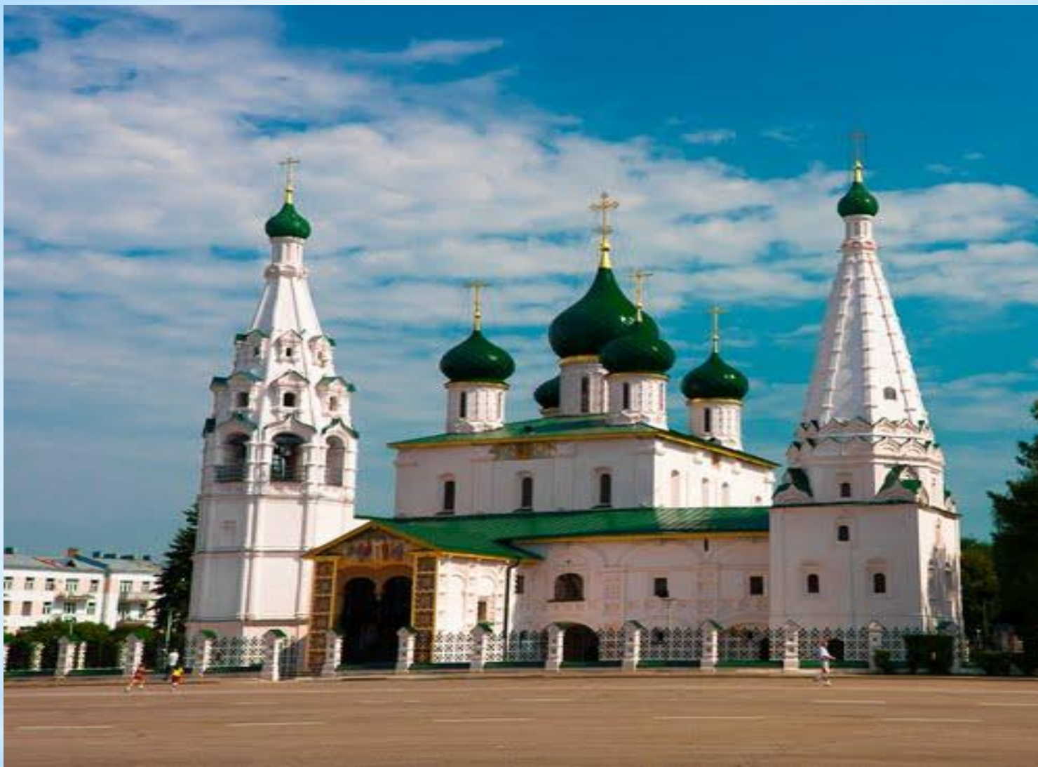
* Церковь Ильи пророка в Ярославле
