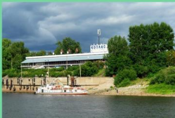
Здание речного вокзала
