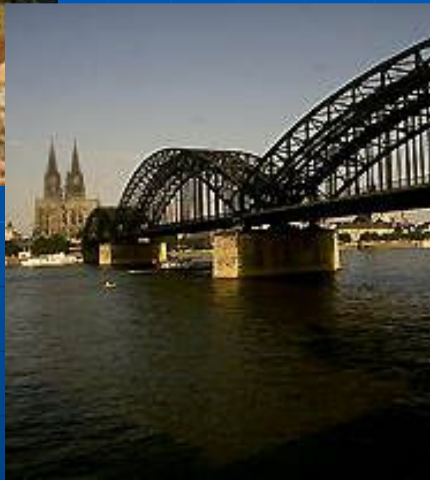
Мост через Рейн.
