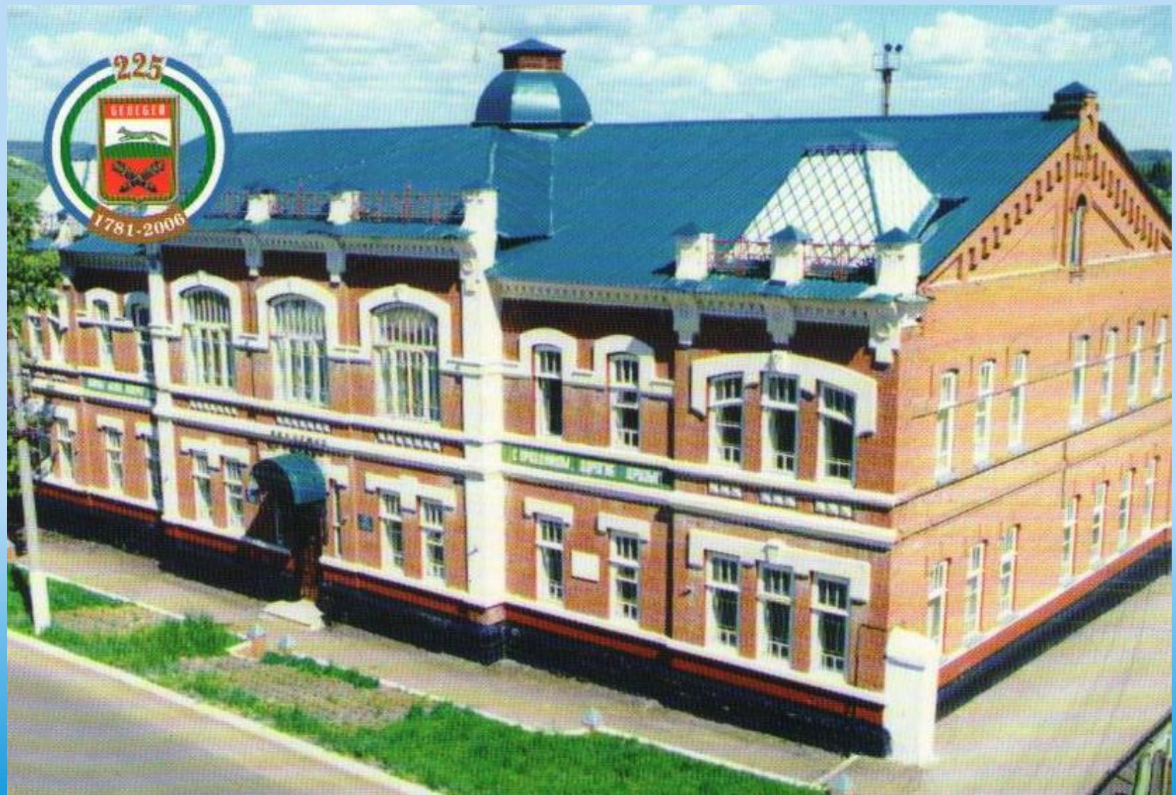
Филиал Самарского государственного архитектурно – строительного университета (здание бывшей земской управы)
