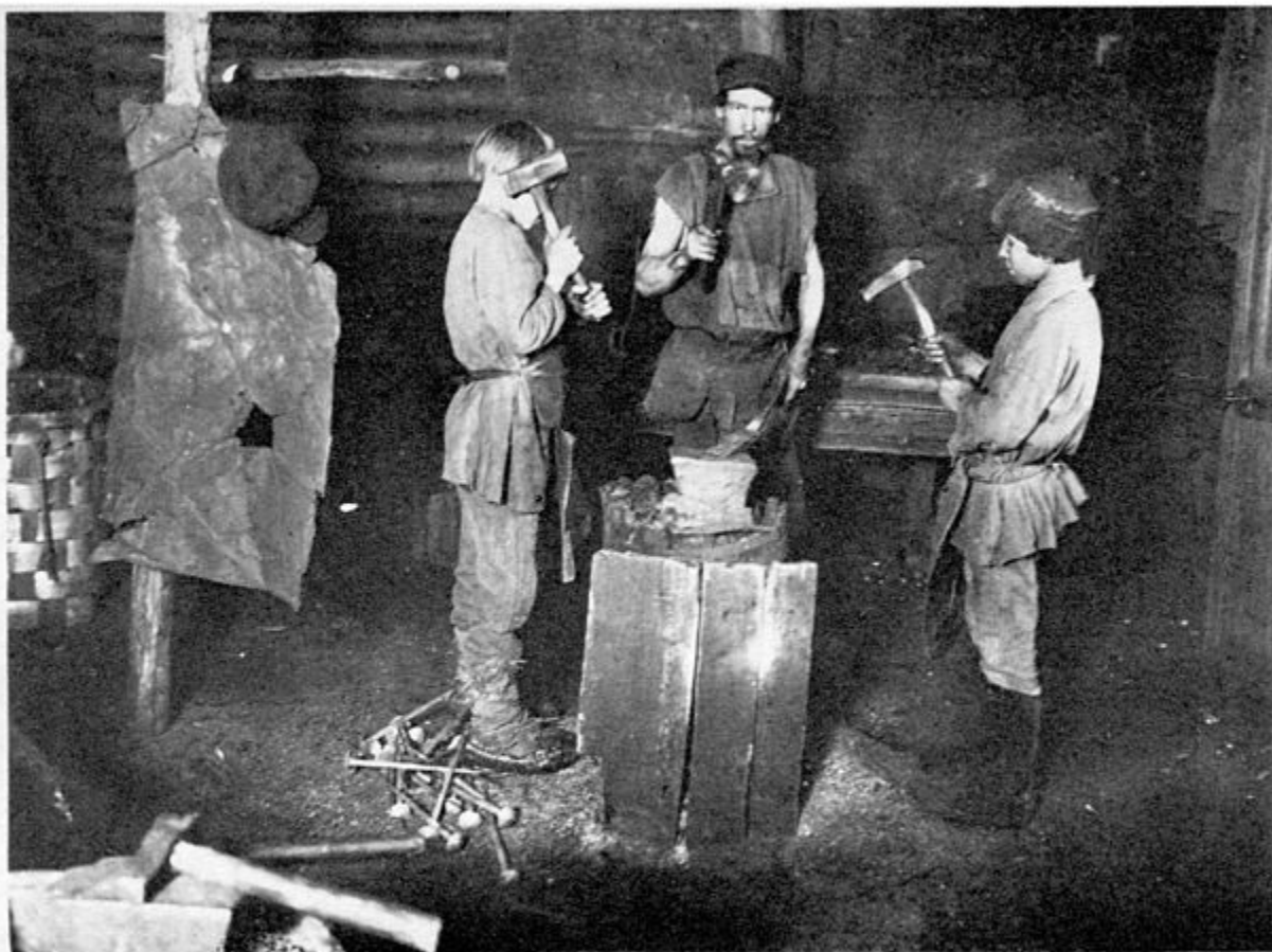
Ковка гвоздей изъ стараго кровельнаго желѣза. Forgeage de clous en vieux fer de toit.
