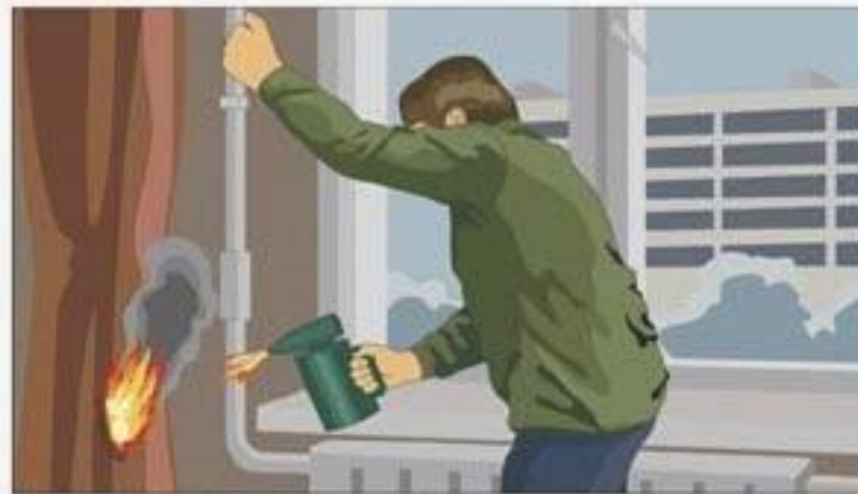
Отогревание замёрзших труб газовыми лампами и факелами
