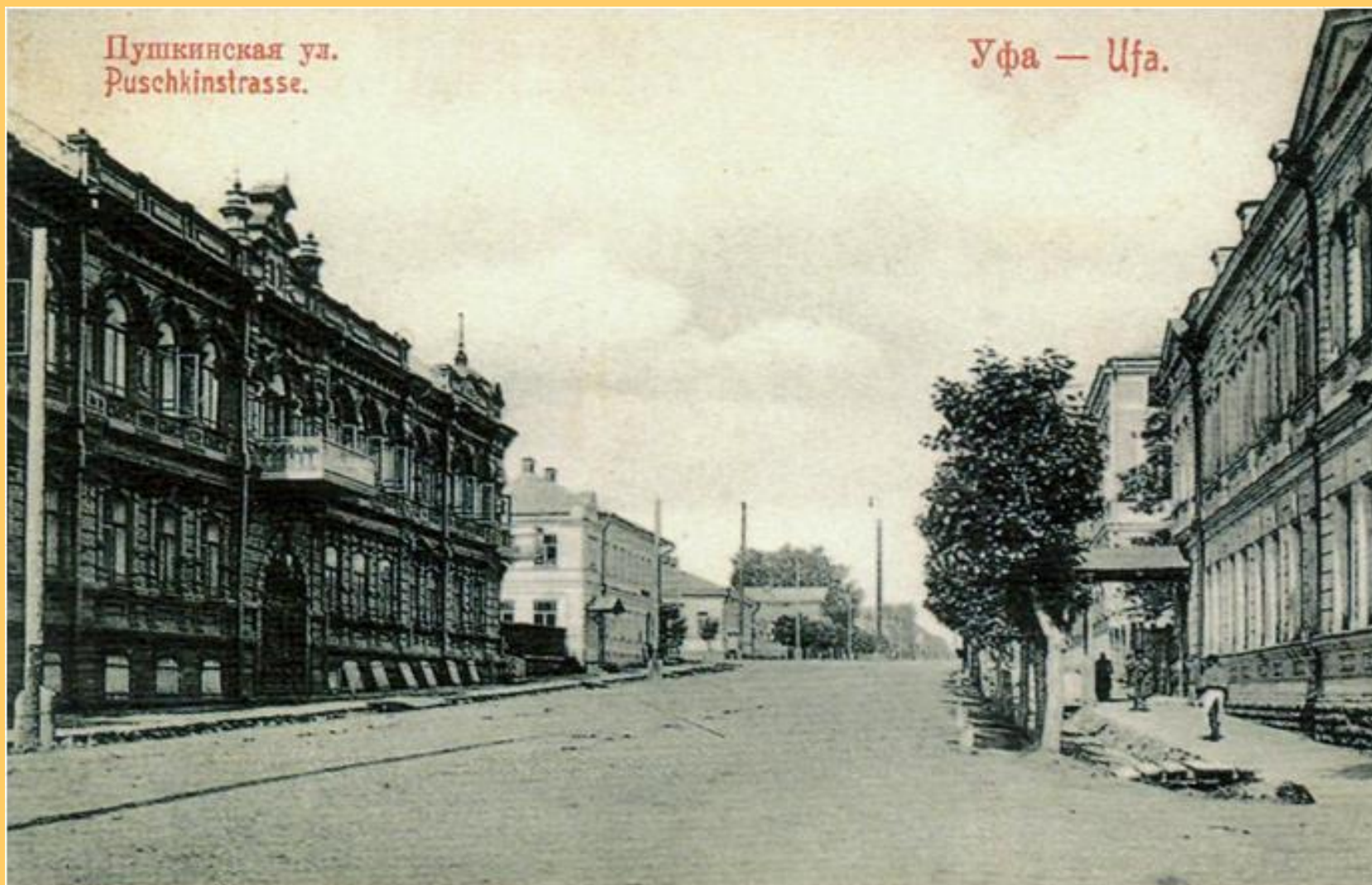
Ул. Пушкинская (Пушкина)
