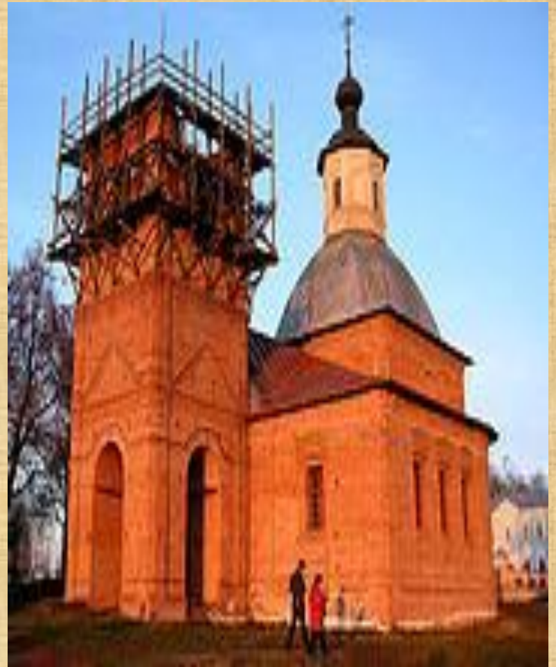
В 2006 году была восстановлена колокольня
