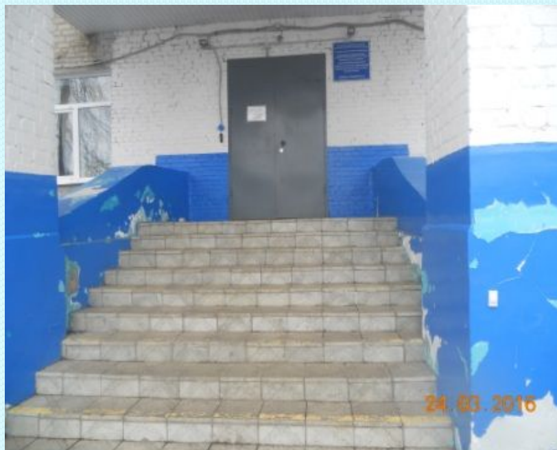
ВХОД В здание до проекта
