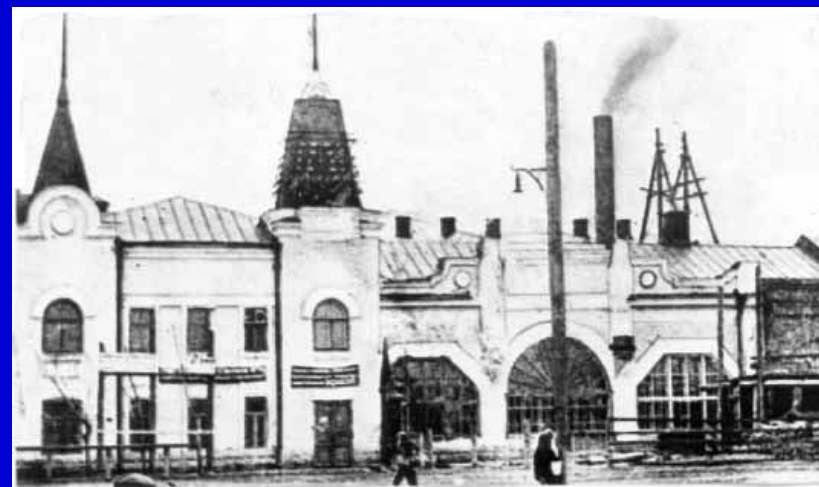
Красноярская городская электростанция введена 18 марта 1912 года - 450 кВт. В 1943 г. имела мощность 6 Мвт.
