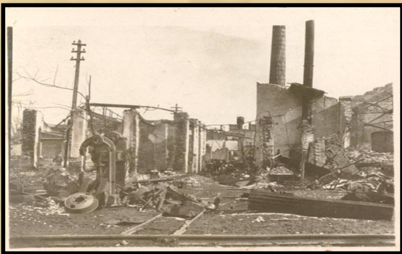
После оккупации. Нефтеперегонный завод в г. Краснодаре
