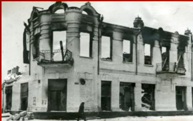
Разрушенное здание аптеки на Центральной улице. 1943 год.
