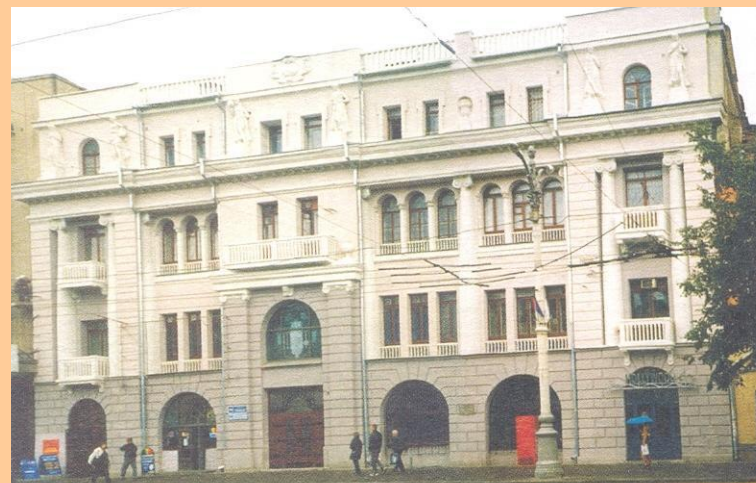
Старое здание кинотеатра. Арх. М.Н. Замятин.
