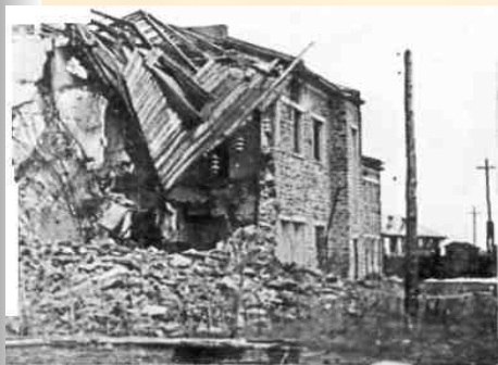
Разрушенная шахта им. Красина
