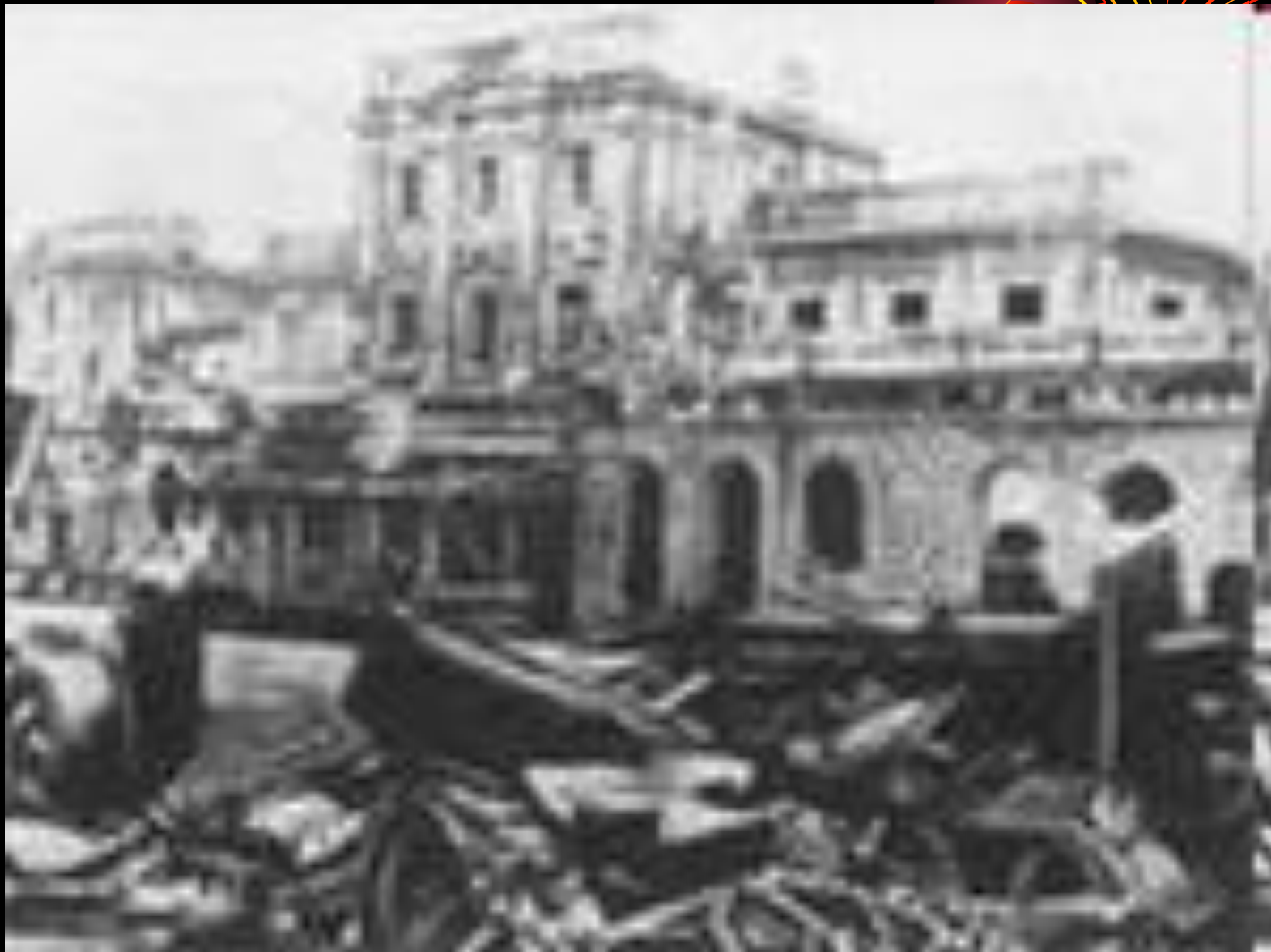
Разрушенный после оккупации Ростов
