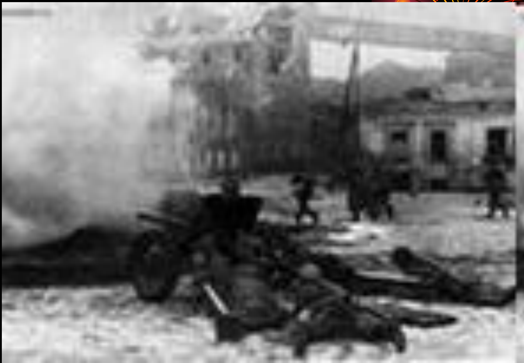
Уличный бой в районе вокзальной площади.
