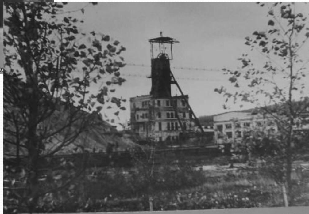
ОБЩИЙ ВИД ШАХТЫ „КАПИТАЛЬНАЯ-2“
