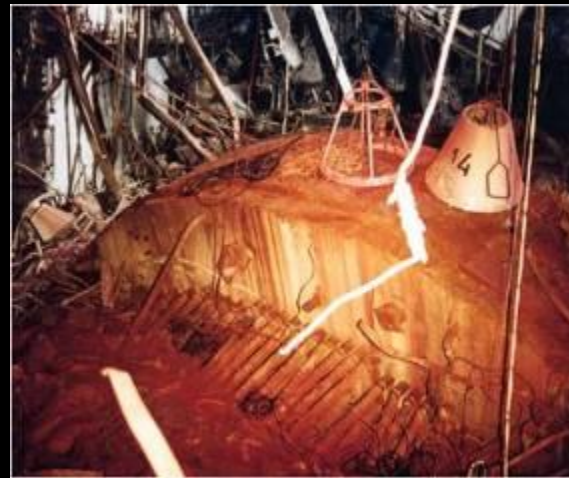
Крышка реактора после взрыва
