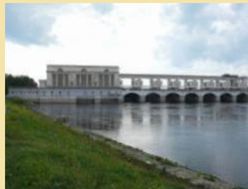
Вид Угличской ГЭС с ул. Спасской
