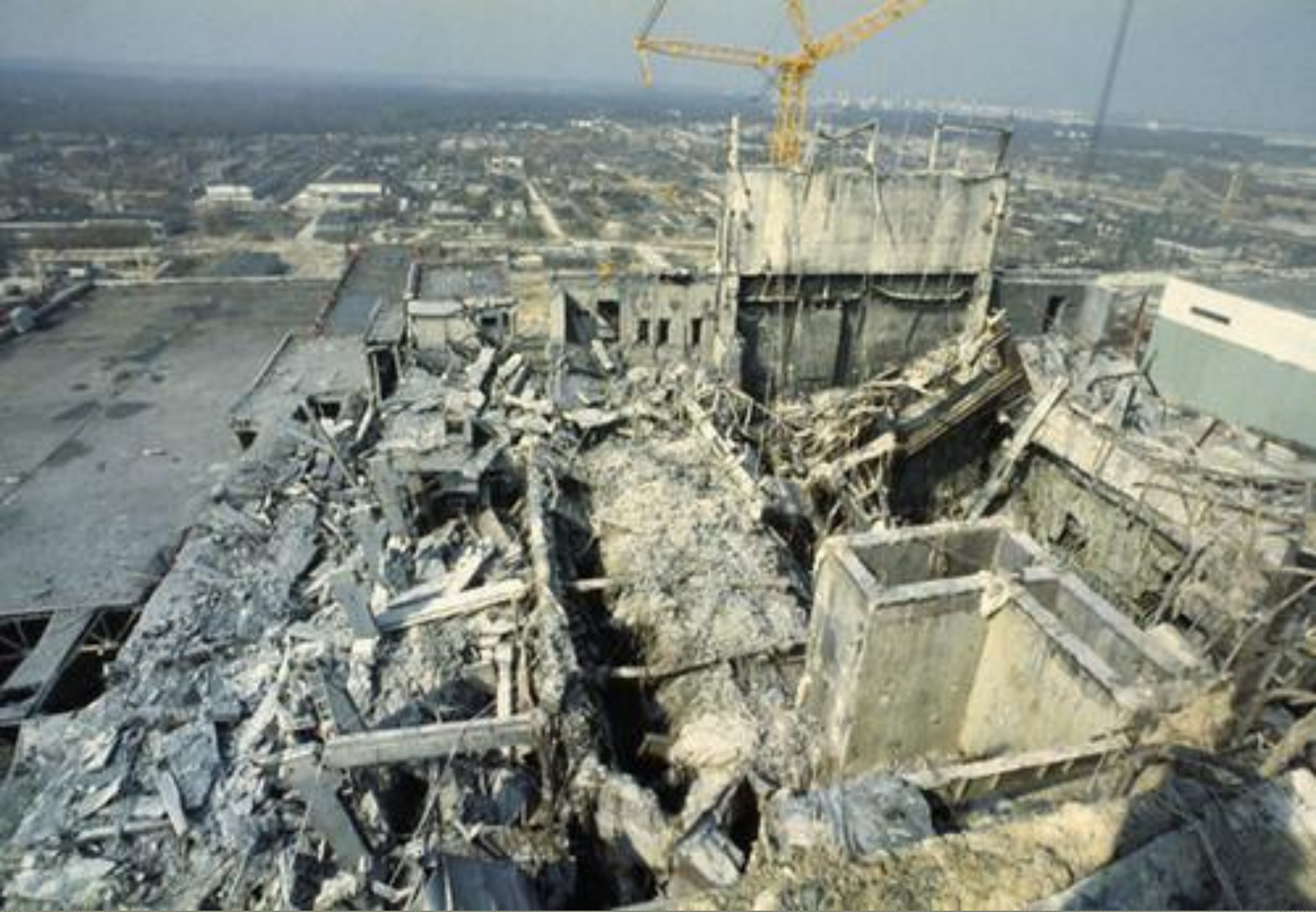
Разрушенный четвертый реактор снят с крыши третьего энергоблока.
