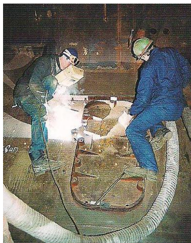
Сварочные работы на атомной подводной лодке
