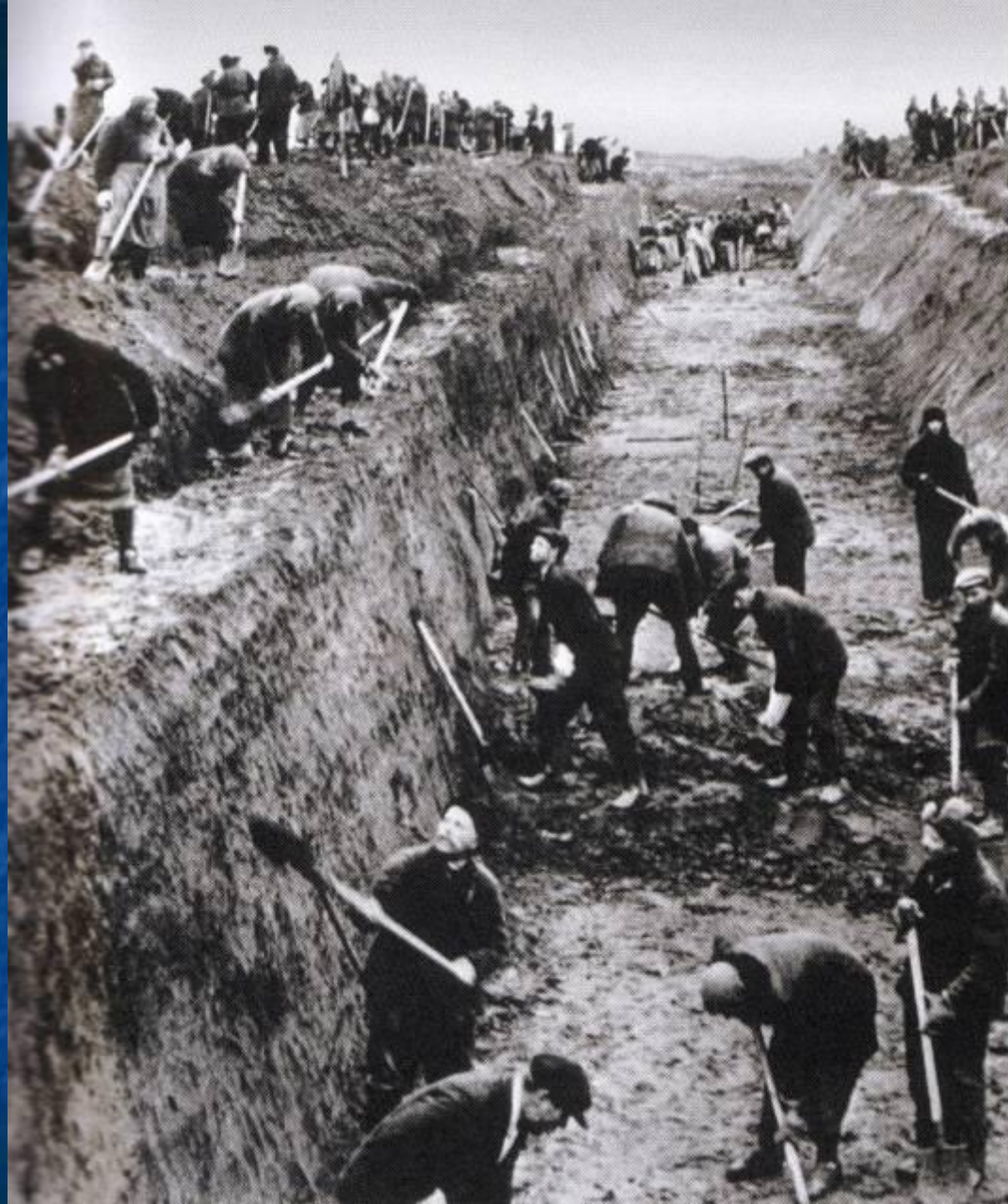
Москвичи на строительстве оборонительных рубежей
