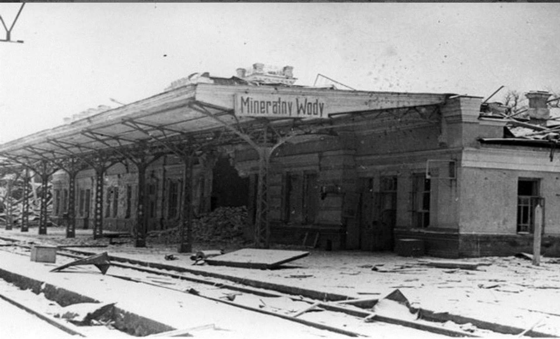
Железнодорожный вокзал ст. Минеральные воды, взорванный гитлеровцами при отступлении. Январь 1943 г. г. Минеральные Воды. Автор снимка неизвестен
